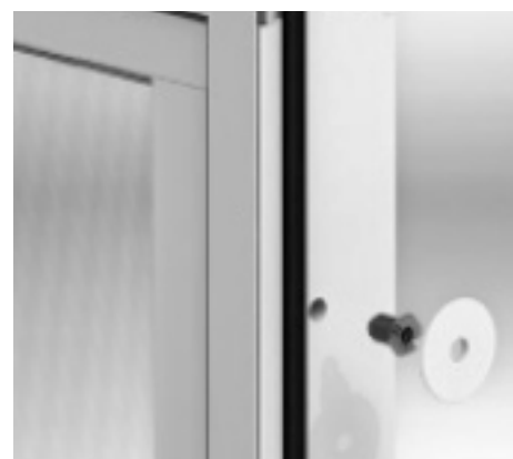
Tryckfördelningsbrickorna pressas fast utifrån på karmhylsorna.
